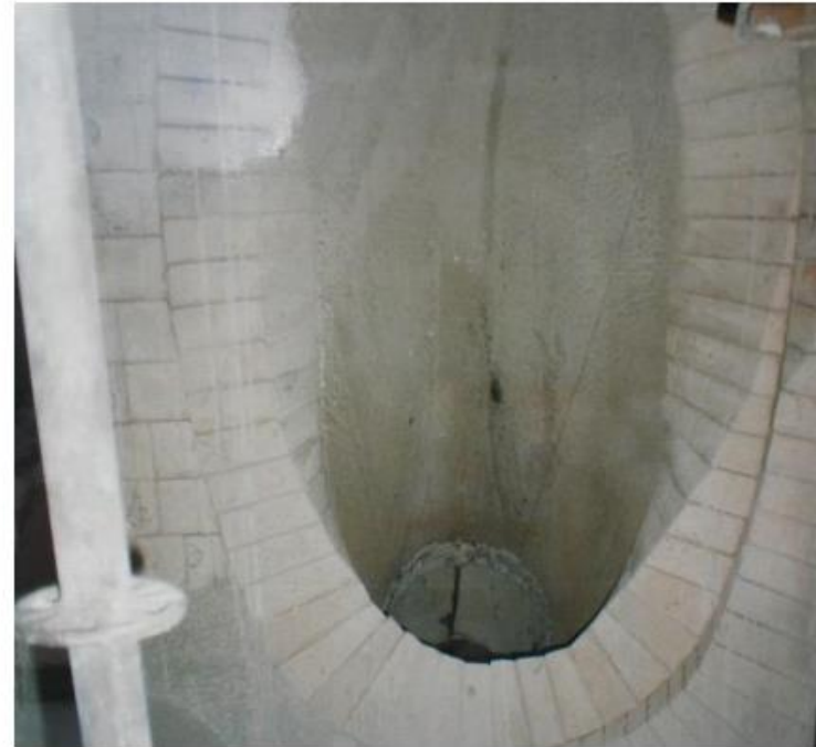
Steinzustellung ohne Risse in den Stutzen
