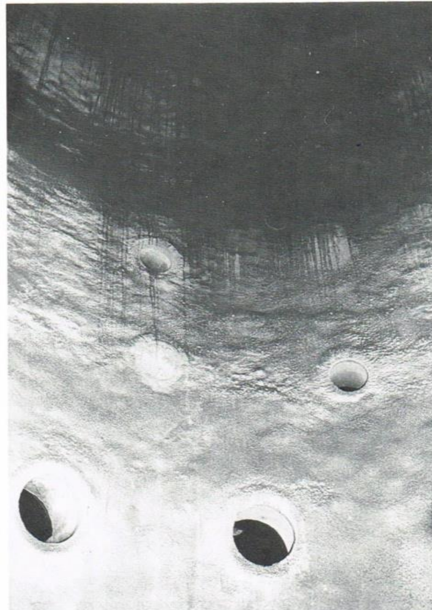
Abb. 8 Unterer Schacht nach der Spritzung
