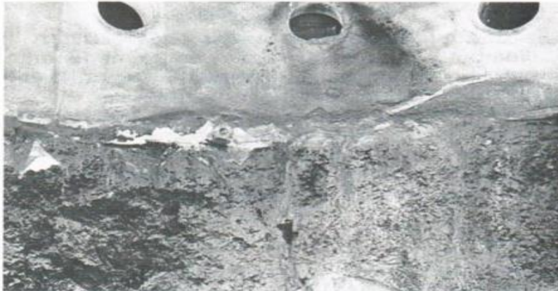
Abb. 7 Blasformebene nach der Spritzung
