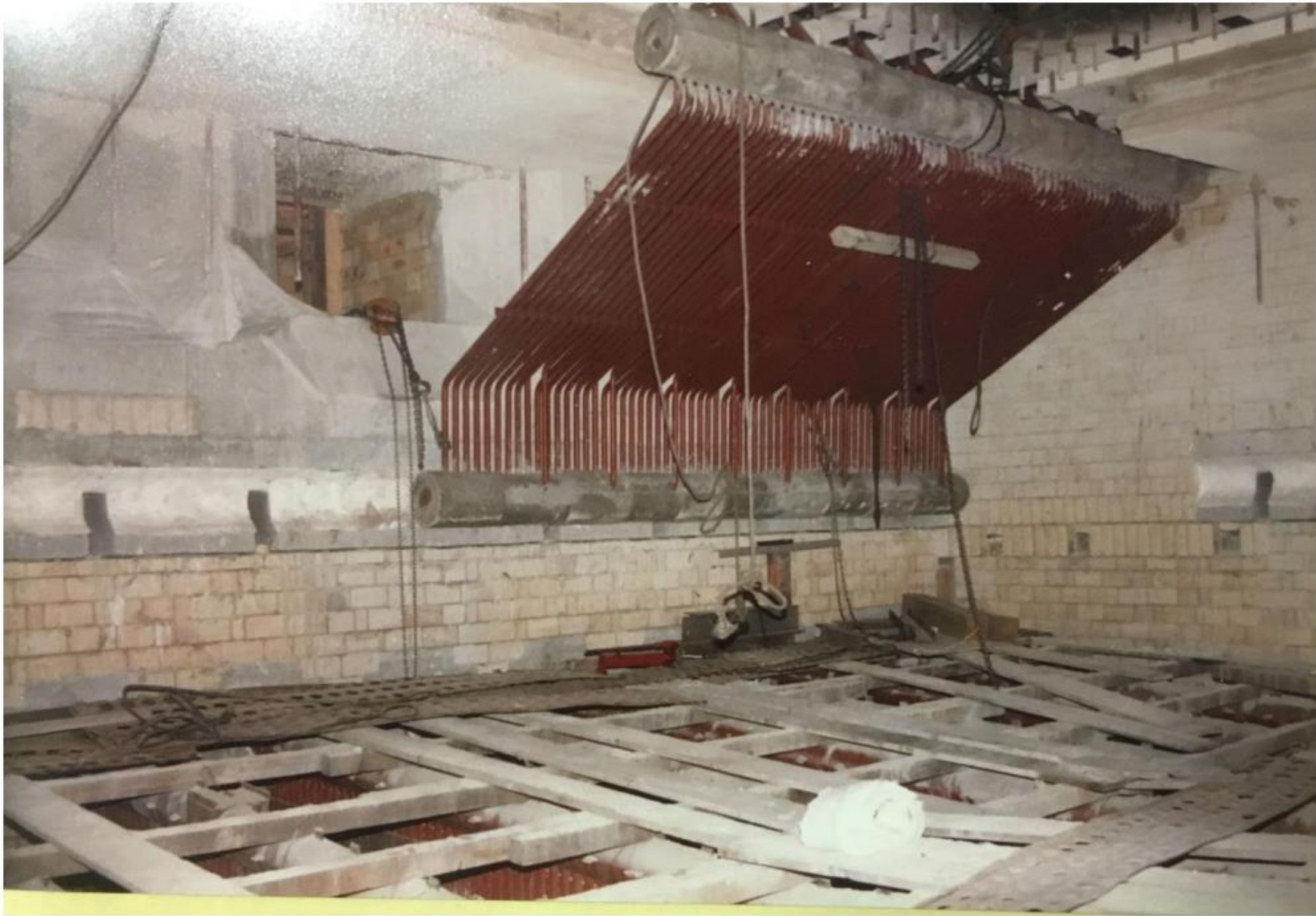
Nach der Ausmauerung Installation der oberen und unteren Wärmetauscher Rohre ohne Bestiftung
