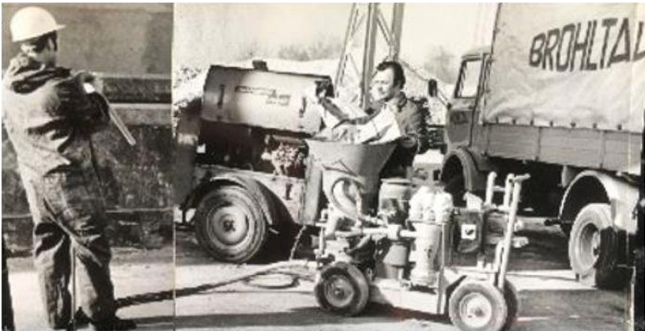
Erste Velco Rotor Trocken Spritzmaschine 1971 (Test mit Theo Aschenbroisch und Martin Buhr) System Micopicola
