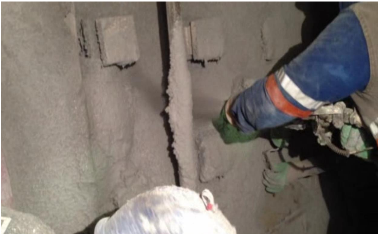
Schlammgespritzten von Isolier- und Verschleißmasse auf 2 Etagen
