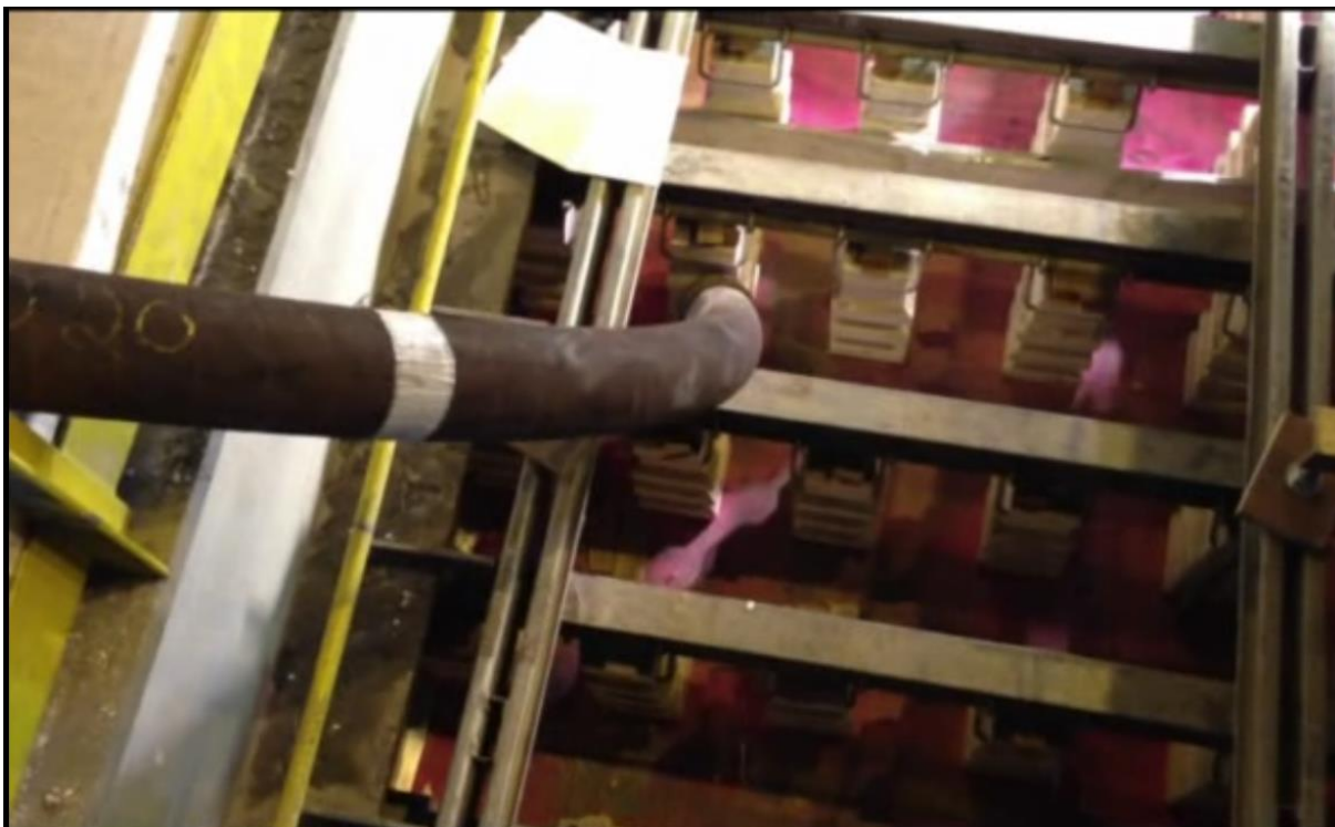
Gießen von Decken mit 2 Kolbenpumpe und vorgeschaltetem Zwangsmischer
