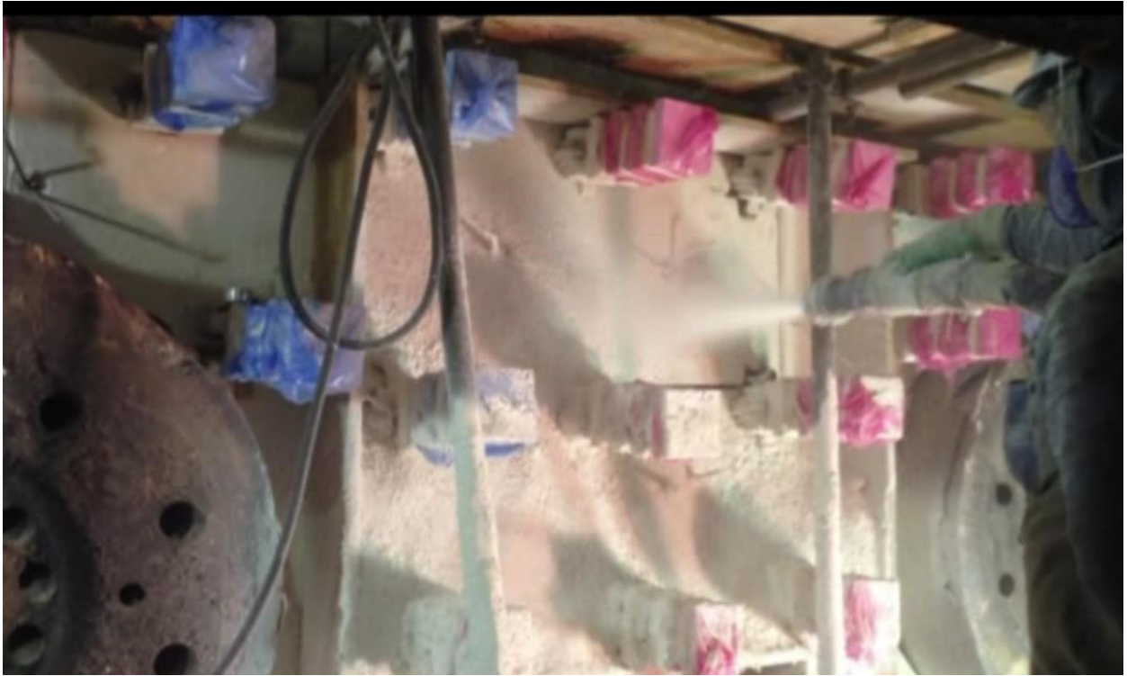
Schlammgespritzten von Isolier- und Verschleißmasse auf 2 Etagen
