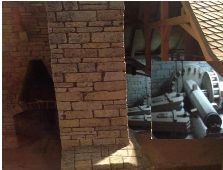
Mit Wasserkraft angetriebener Blasebalk zum Einblasen der Verbrennungsluft
