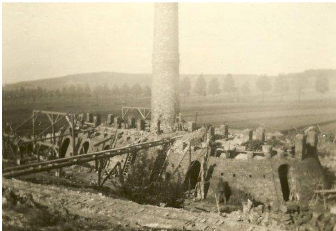
Bau des ersten – Ofens - Chamotte Ringofens 1925
